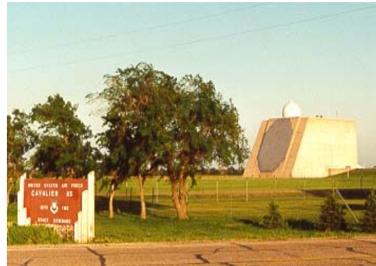
Fig. 15-10. PARCS Radar Site
